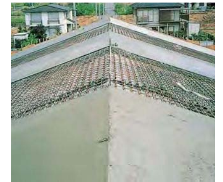
傾斜屋根コンクリート打ち
