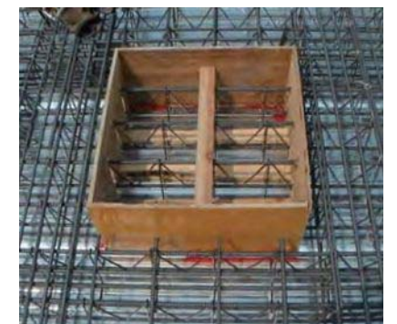
開口処理用コンクリート流れ止め
